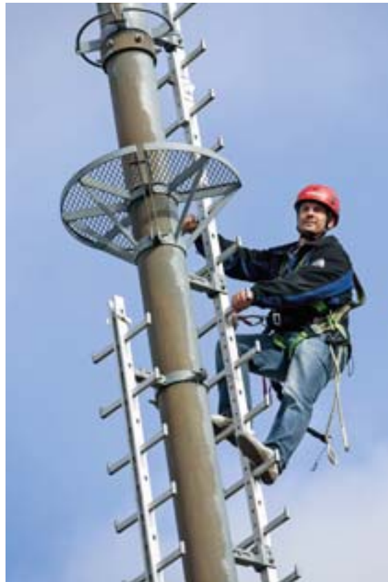
Der sichere Aufstieg und die Rettung an Masten kann mit verschiedenen Höhensicherungsgeräten optimal trainiert werden.
